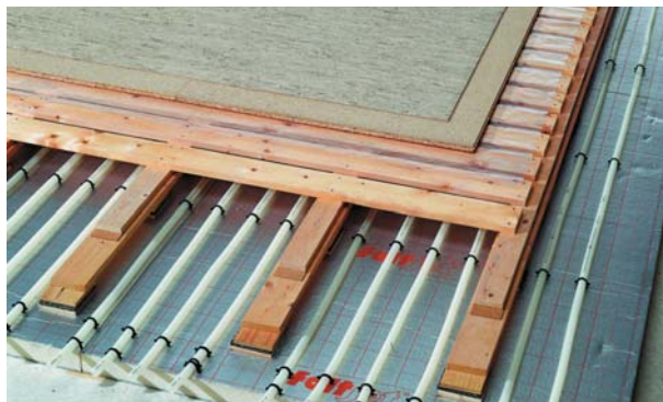
▲ Budowa grzejnika podłogowego – podłóże sprężyste
